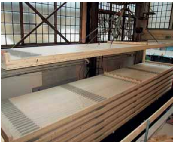
Bild links: Die vorgefertigten Brettschichtholzelemente mit Dichtungsfolie und eingeklebten HBV-Verbindern wird eingehoben
