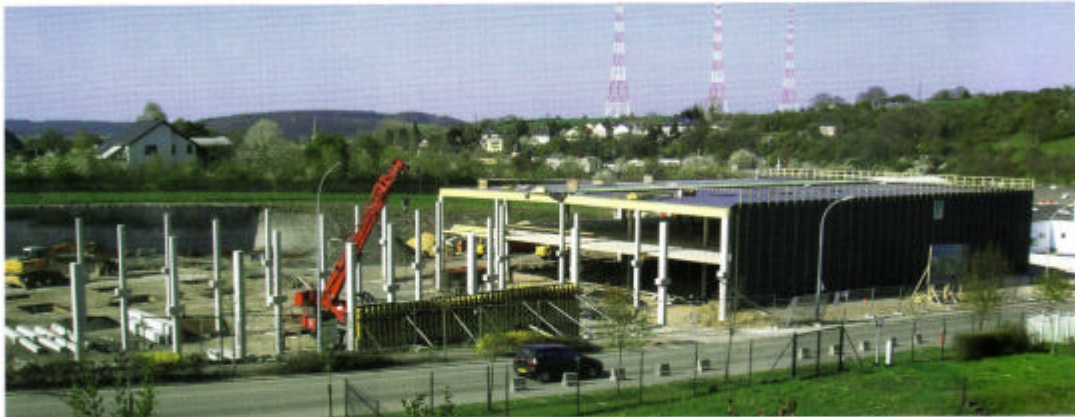
Bild 1 Auf den zweiten Blick eine „normale“ „Beton“-Baustelle ...
