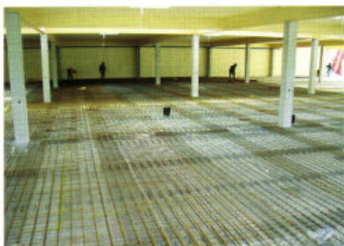
Bild 8 Die Bewehrung ist verlegt, fertig zum Betonieren der Deckenoberseite.
