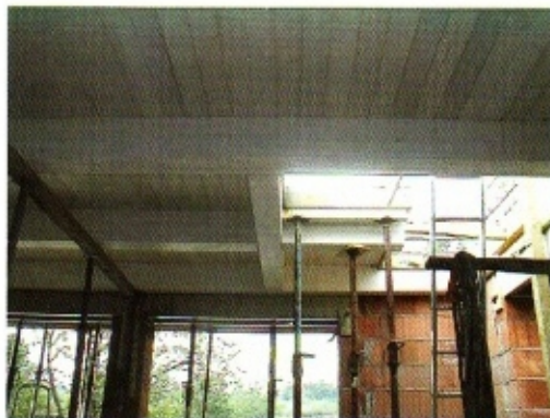
Bild 6: Untere Auswechslung mit BS-Holz-Unterzügen
