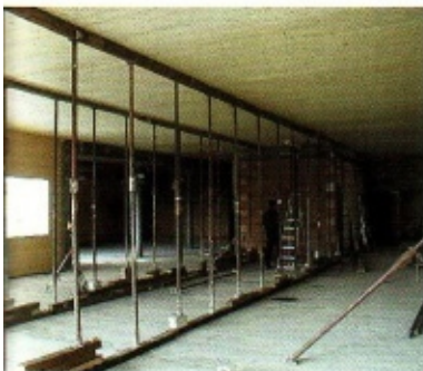
Bild 1: Überhöhung der BS-Holz-Fladen mittels zwei Spriß-Reihen
