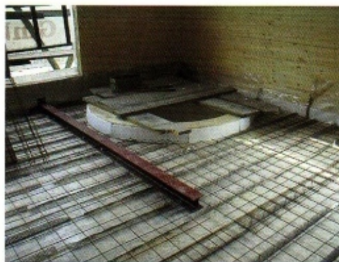
Bild 7: Obere Auswechslung mit Stahlträger
