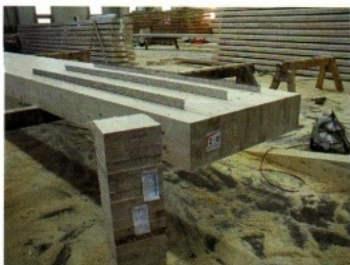
Bild 3: Versuchs-träger mit den ersten, einklebten Schubverbindern aus Rippenstreckmetall
