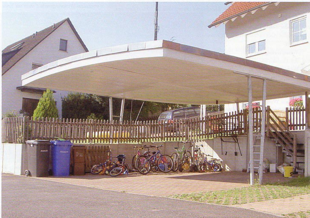
Bild 1 Carport auf drei Stahlstützen mit unterseitiger Holzansicht. Um leicht in die später dort parkenden beiden PKWs ein- und aussteigen zu können, sollte auf eine mittlere Unterstützung verzichtet werden.
