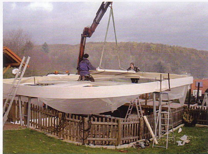
Bild 5 Verlegen der BS-Holz-Plattenelemente. Die umlaufende Randeinfassung besteht aus BS-Holz.
