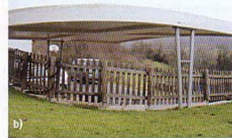
Bild 3 Seitliche Stützenpaare mit Queraussteifung. Die drei Stahlseil-Abspannungen (siehe Bild 2) sind hier ( Bild 3b ) noch nicht montiert.
