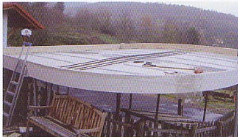
Bild 6 Carport mit aufgelegter Schalung und Zusatzbewehrung für zugbeanspruchte Bereiche im Beton
