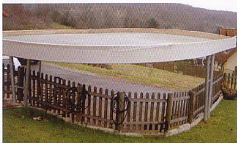
Bild 8 Ausgehärtete Betonschicht. Überstehende Randeinfassung
