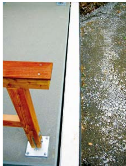
Bild 12 Aus dem Brückenbau bekannte Dehnfuge für mögliche Längsverformungen der Brücke.
