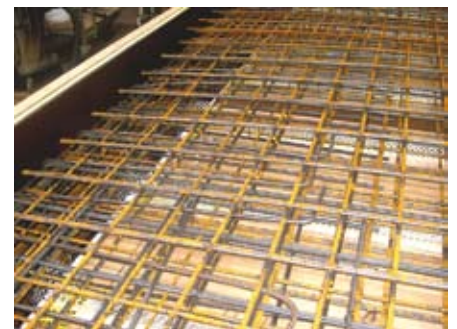
Bild 5 HBV-Brückenelement vor dem Betonieren. Obere und untere Mattenbewehrungslage inklusive umlaufender Steckbügel
