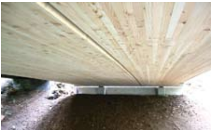
Bild 8: Unteransicht der Brücke: flachliegende Brettschichtholzelemente
