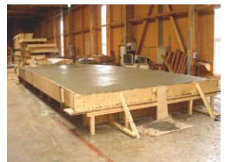
Bild 6 HBV-Brückenelement nach dem Betoniervorgang
