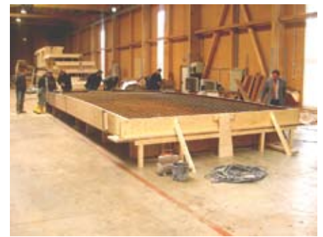
Bild 4 Vorgefertigtes HBV-Brückenelement vor dem Betonieren
