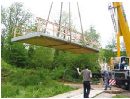
Bild 7 Verlegen der komplett vorgefertigten Brücke inklusive montierter Geländer auf der Baustelle
