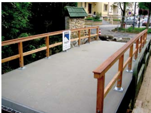
Bild 1 Holz-Beton-Verbundbrücke in Kayl: Weltweit erste Brückenkonstruktion mit eingeklebten Streckmetallen als Verbindungsmittel
