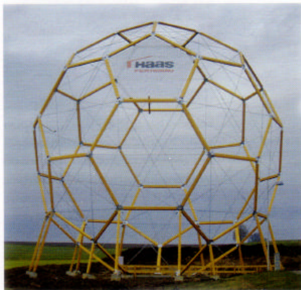
Bild 1 Der Fußball, Durchmesser 25 m, wurde als „Aufmacher“ für das Haas-Frühlingsfest und längerwährend als Werbung für den konstruktiven Holzbau gebaut. Mit dem wahrscheinlich größten Holz-Fußball der Welt wäre zumindest diesbezüglich die Meisterschaft schon errungen. Der Eintrag in das Guinness Book of Records ist beantragt.
