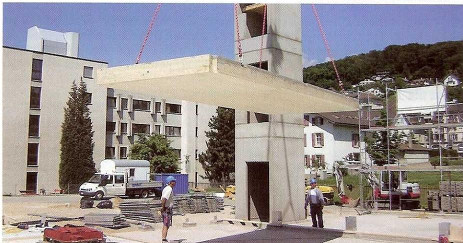
Nach dem Bau des Fahrstuhlschachtes wurden die vorgefertigten Wände, Fassaden, Decken und Böden montiert. (Bilder: Robin Wirz, Erne AG)
