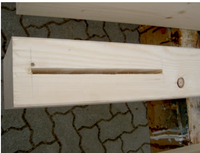
Abb. 6: Detailansicht der Schlitzung (mit Kettenstemmer) für das Einkleben der Lochbleche
