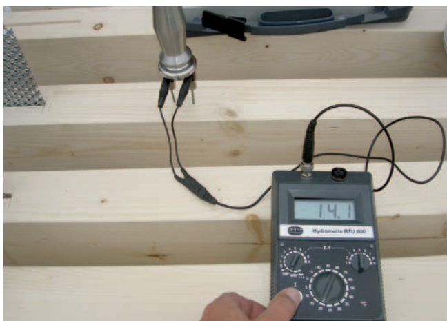
Abb. 8: Messung der Holzfeuchtigkeit der Sparren
