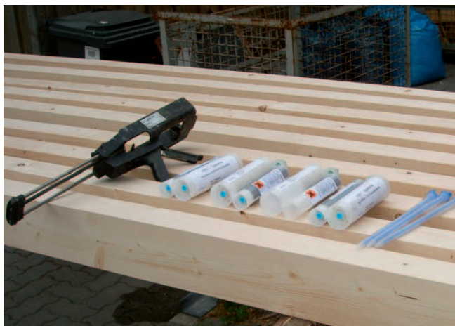
Abb. 7: Ansicht der Sparren während des Herstellvorgangs – Ein- kleben der Lochbleche mit in Kartuschen abgefülltem 2K-Polyurethanklebstoff
