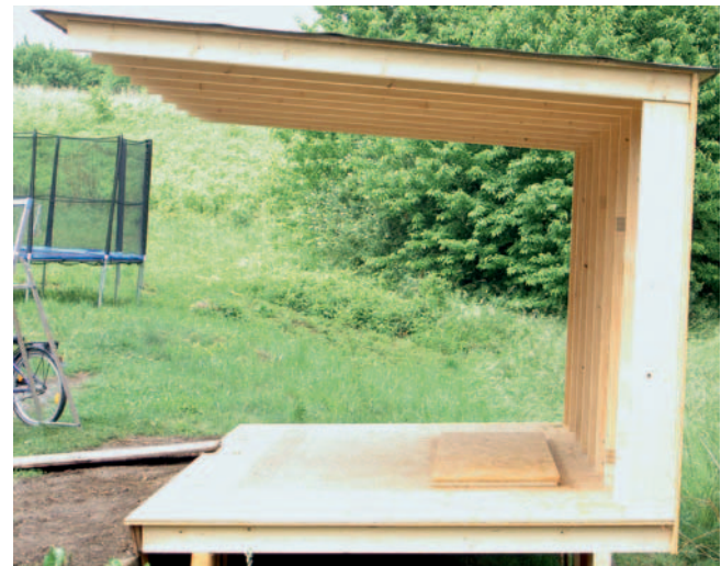
Abb. 1: Experimentalbau Fahrradunterstand – Geometrische Form eines liegenden „U“ mit einer Auskragung der Sparren von 300 cm
