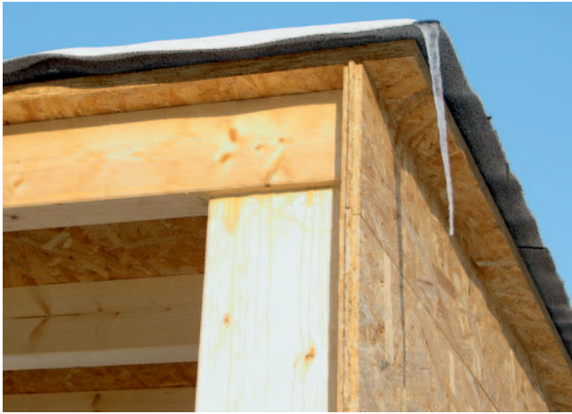
Abb. 5: Detailansicht der Ecke des Experimentalbaus im Winter – OSB-Beplankung der Rück- wand und des Daches sowie Bitumenbahn als Dachabdich- tung
