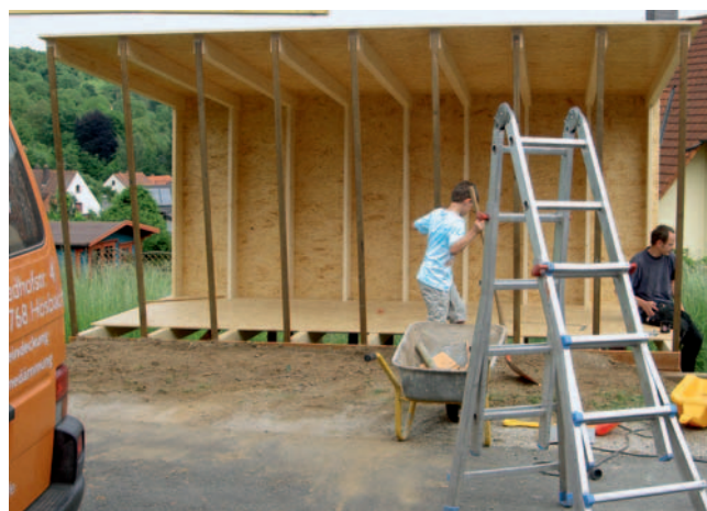
Abb 10: Abstützung der Rahmenkonstruktion durch aufgenagelte Latten während der Bauphase
