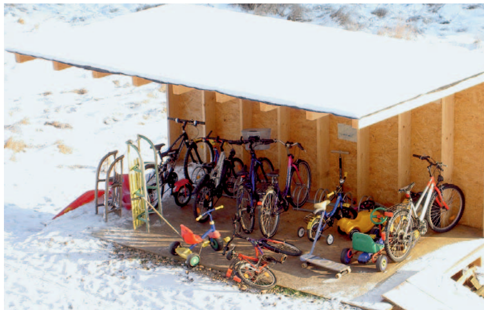
Abb. 11: Fahrradunterstand im Betrieb – statisch bemessen für eine Beanspruchungskombination aus Eigengewicht, Schnee und Wind
