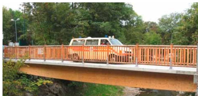
**Beispiel für das Holz-Beton-Verbundsystem:** In Purkersdorf bei Wien wurde diese Brücke in der innovativen Bauweise realisiert
