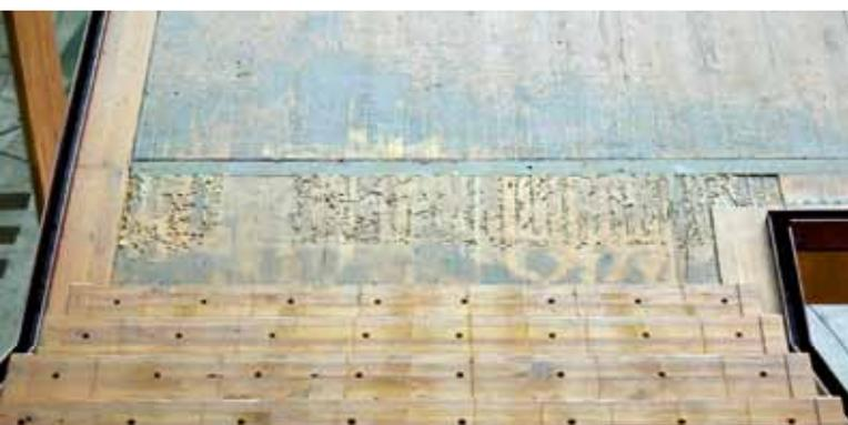
**Detail der UBC-Stiege:** Von oben fotografiert werden die Lochbleche und Klebefugen sichtbar, die mittlerweile vom Bodenbelag verdeckt sind
