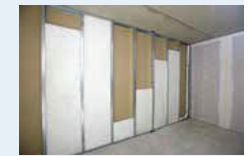
Trennwände mit Glaswolle: Leichtbau auch im Inneren eines Erweiterungsbaus. www.ursa.de
