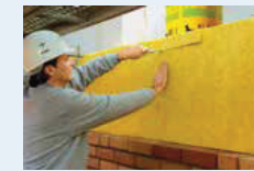
Massiver Anbau mit Kerndämmung und Backstein-Vorsatzschale. www.isover.de
