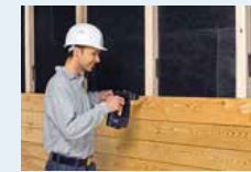
Aufstockung mit Ständerwerk Dämmung und Wetterschutzschale. www.isover.de
